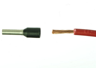
Entfernen der Isolation am Kabelende.
