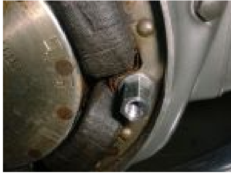
Abbildung 2.a Montage der Abstandsbolzen.
